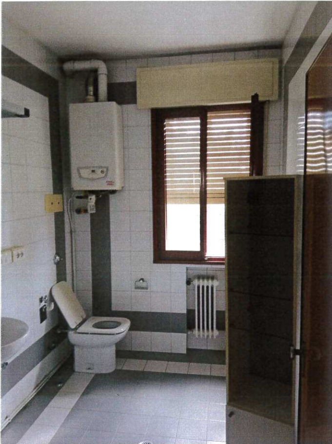
APPARTAMENTO PIANO PRIMO – BAGNO (RIPOSTIGLIO)
