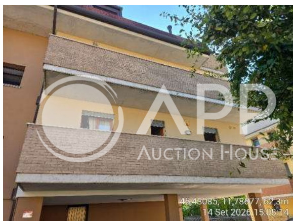
Prospetto fronte retro
